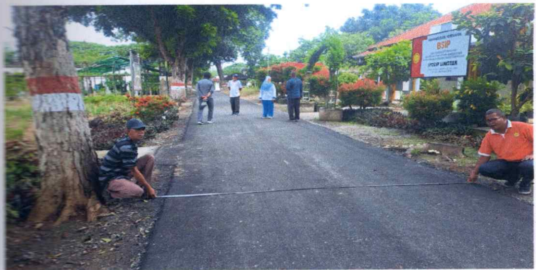
Foto Pemeriksaan akhir pekerjaan
