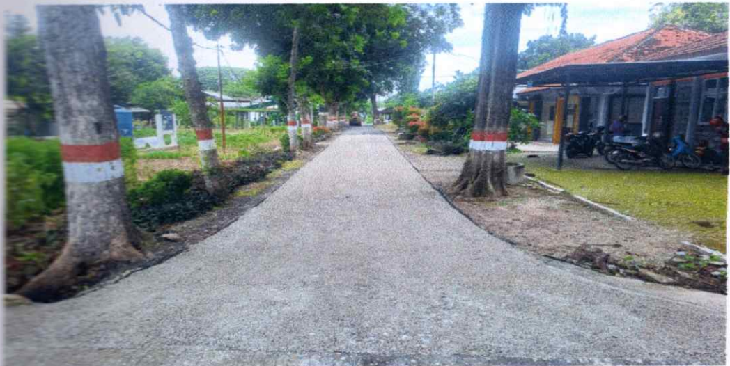
Foto Pekerjaan Leveling Penetrasi Macadam
