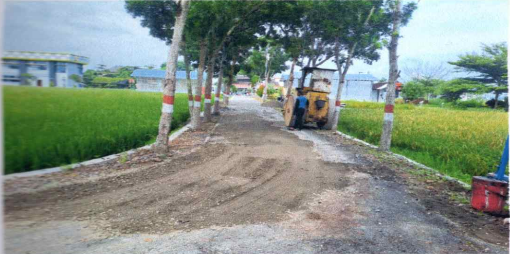
Foto Pekerjaan LPA
