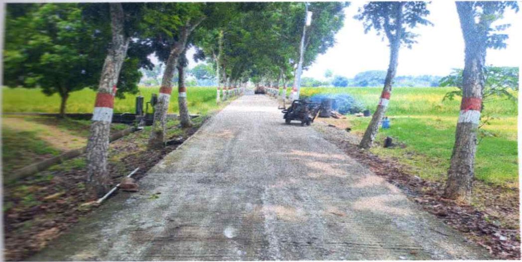
Foto Pekerjaan Leveling Penetrasi Macadam
