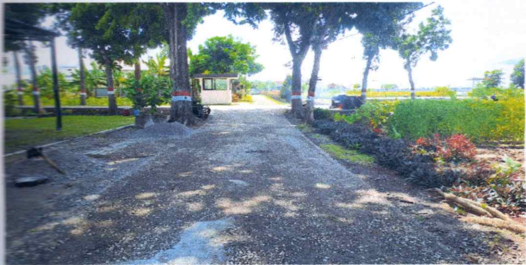
Foto Pekerjaan LPA
