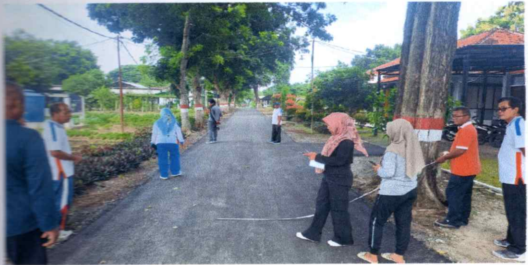
Foto Pemeriksaan akhir pekerjaan
