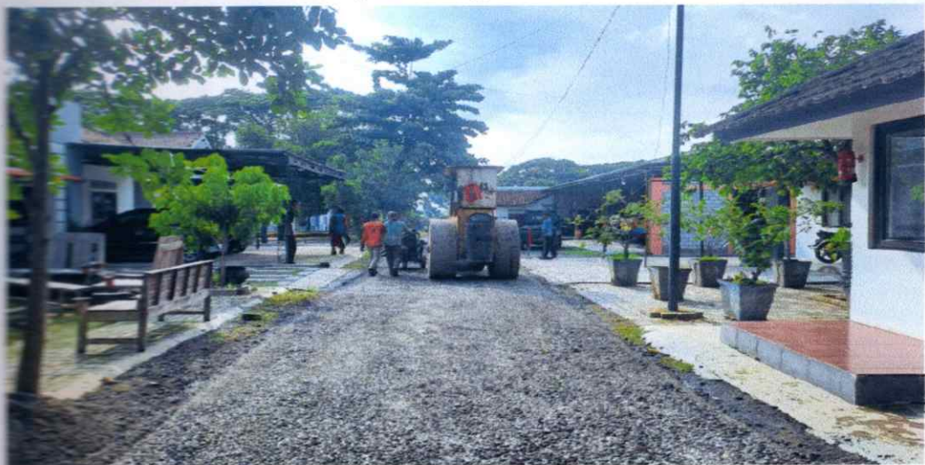
Foto Pekerjaan Leveling Penetrasi Macadam
