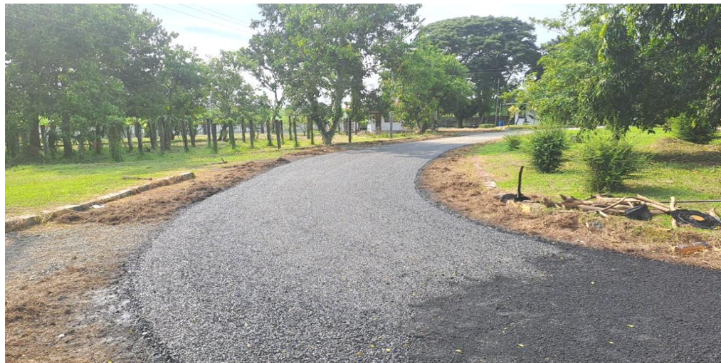
Foto 50 % Jalan Kompleks perumahan
