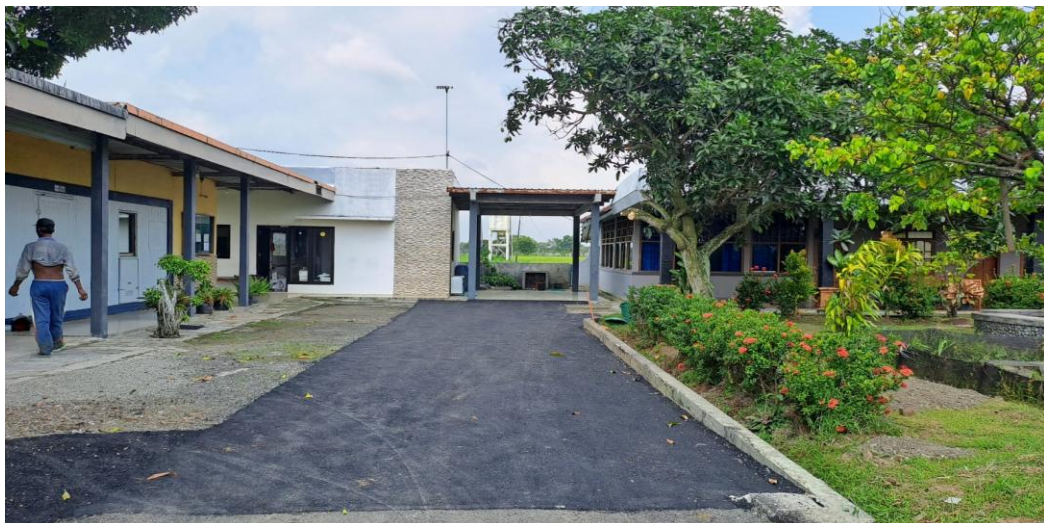
Foto 100 % Jalan menuju Lab. GRK lama
