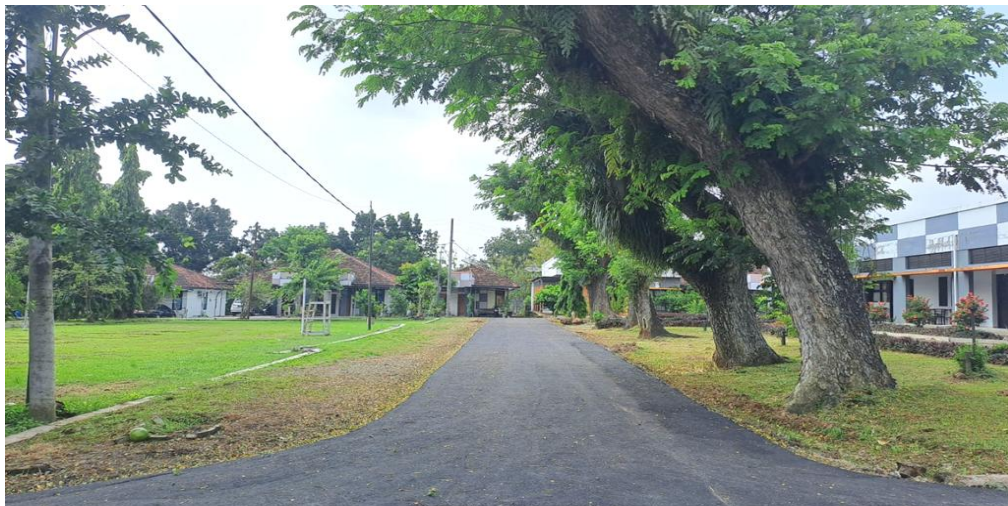
Foto 100 % Jalan Kompleks perumahan
