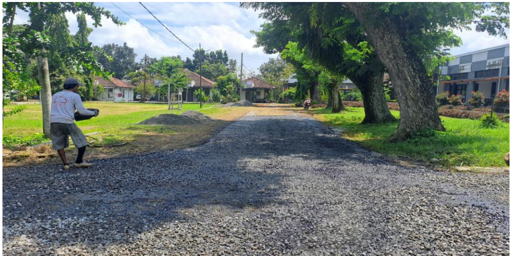
Foto Pekerjaan Leveling Penetrasi Macadam
