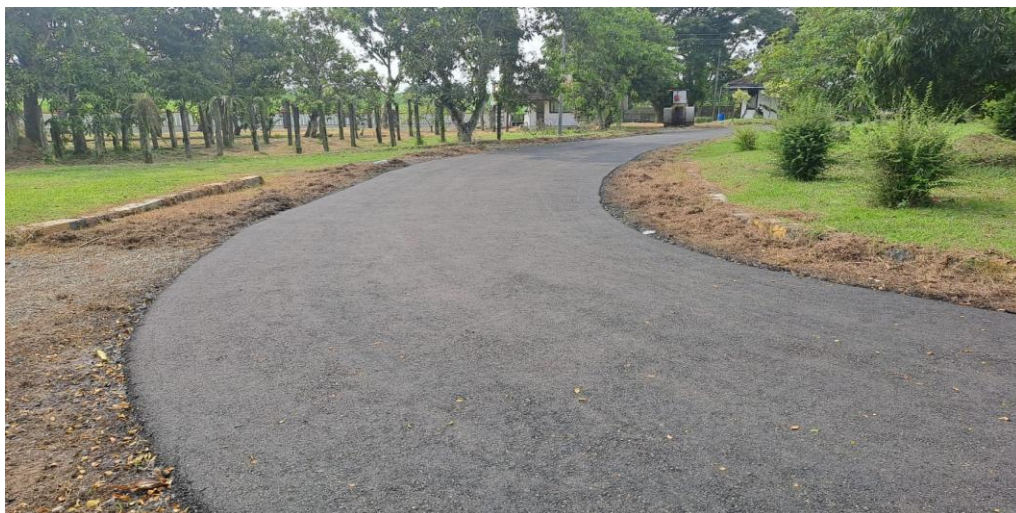
Foto 100 % Jalan Kompleks perumahan
