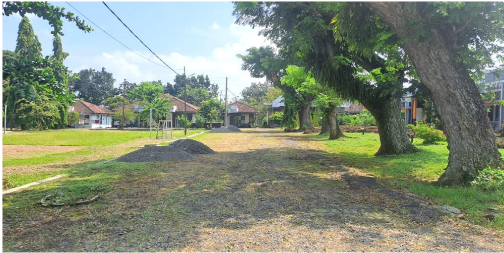
Foto 0 % Jalan Kompleks perumahan
