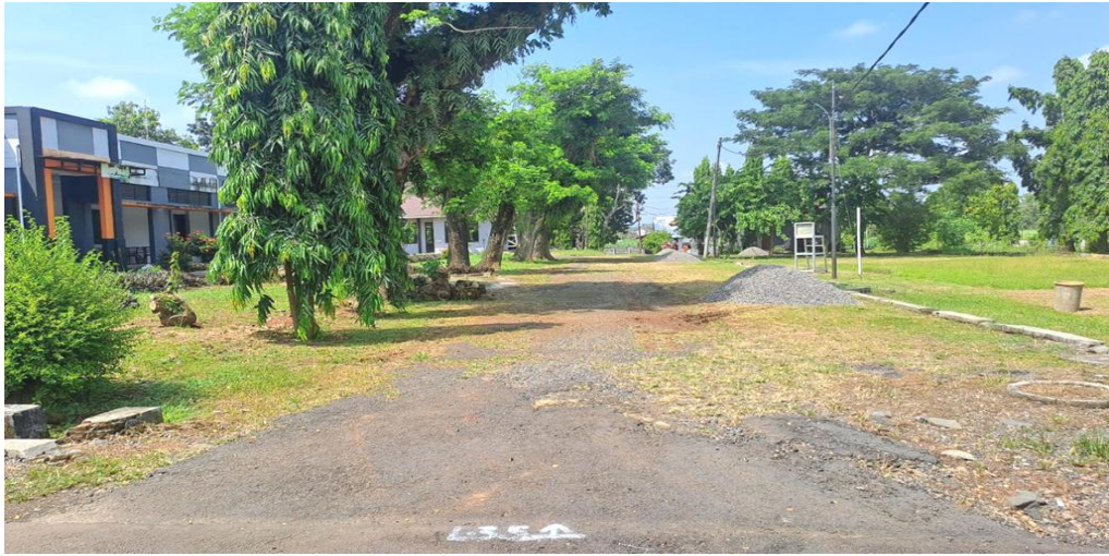
Foto 0 % Jalan Kompleks perumahan
