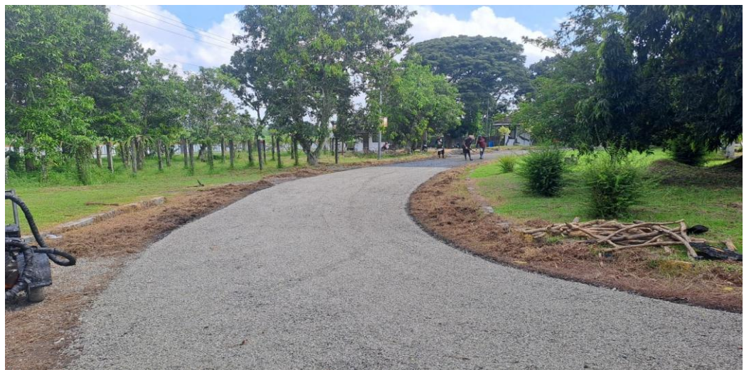
Foto Pekerjaan Leveling Penetrasi Macadam
