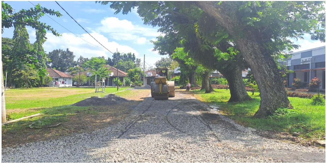
Foto Pekerjaan Leveling Penetrasi Macadam
