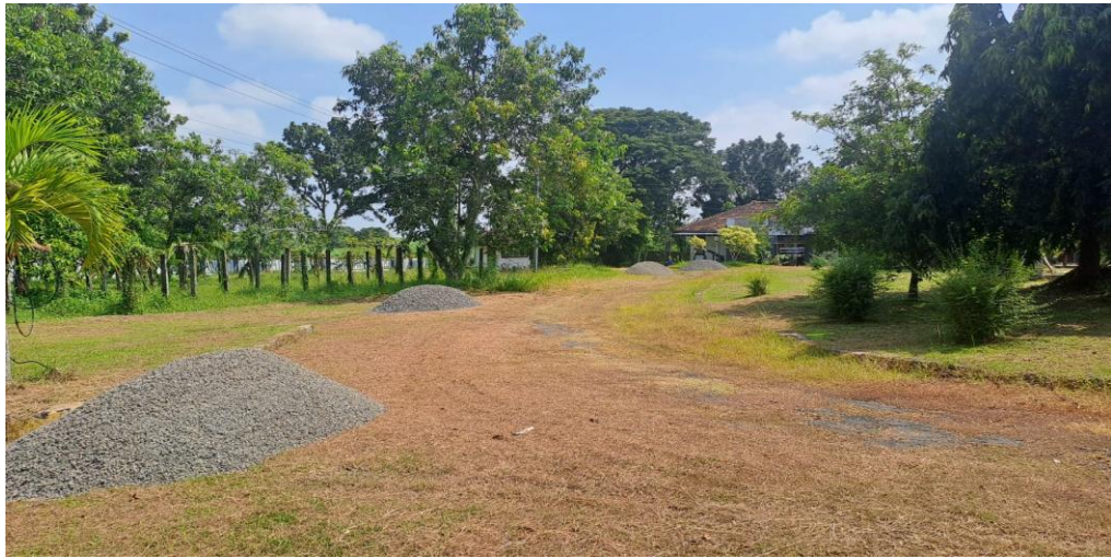
Foto 0 % Jalan Kompleks perumahan
