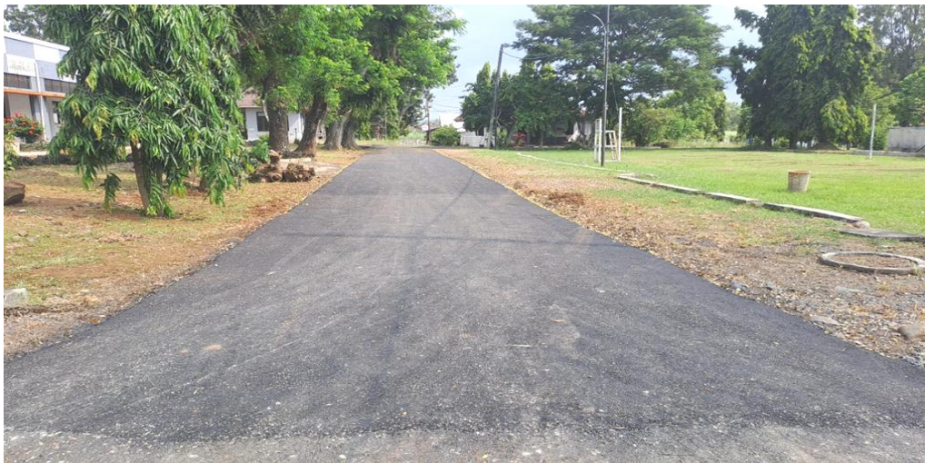
Foto100 % Jalan Kompleks perumahan
