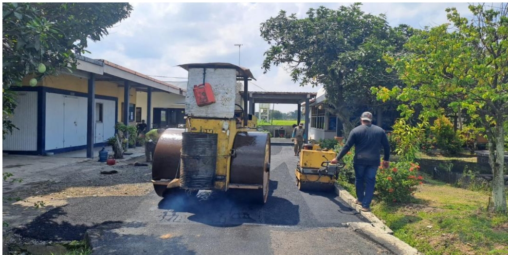
Foto 50 % Jalan menuju Lab. GRK lama
