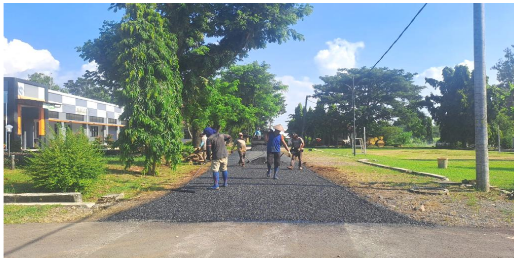
Foto 50 % Jalan Kompleks perumahan
