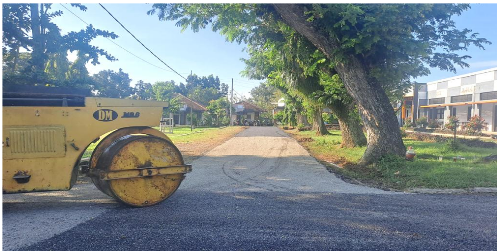
Foto 50 % Jalan Kompleks perumahan
