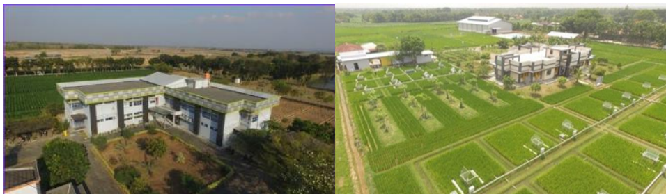
Gambar 7. Gedung Laboratorium BRMP Lingkungan Pertanian
