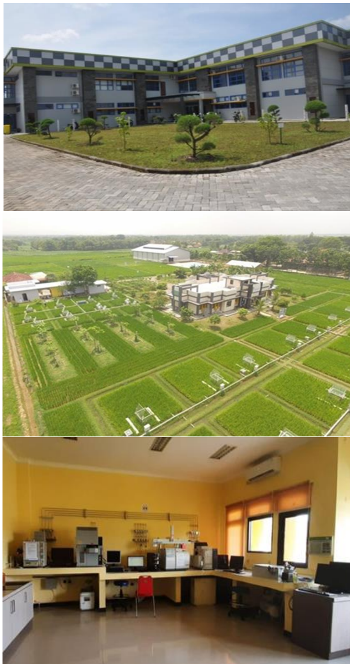
Gambar 3. Gedung dan Sarana Laboratorium BPSI Lingkungan Pertanian
